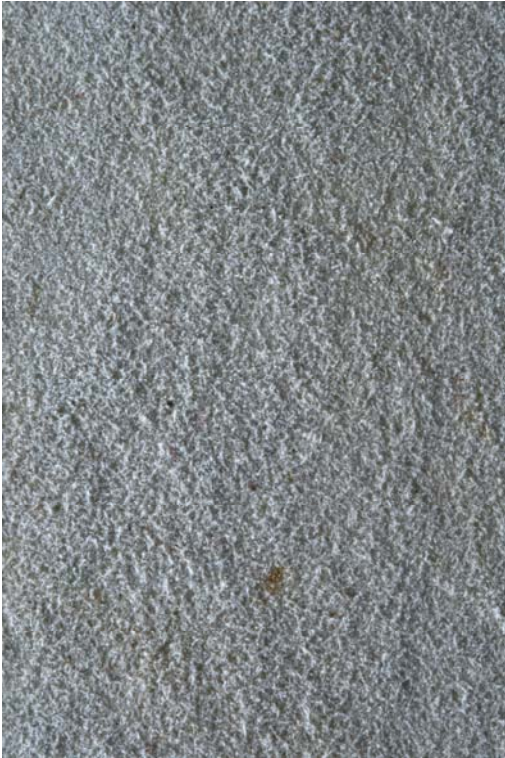
Abb. 2 Die noch nicht abgelöste samtige Oberflächenstruktur. Wenn man mit den Fingern über die beiden Stellen streicht, ist der Unterscheid noch spürbarer als auf dem Foto.
